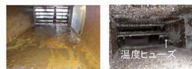
図6 排気ダクト・防火ダンパーに吸着した油塵
