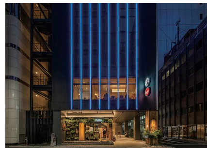
外装のアルミカーテンウォールにLED照明を組み合わせた事例
