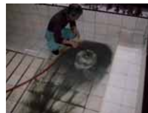
【写真-2】連通管の洗浄
