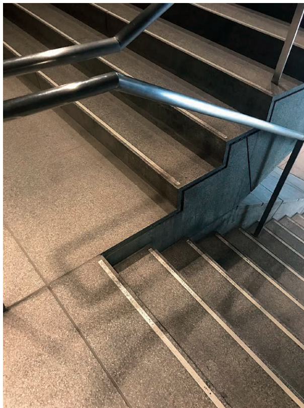
不安な階段：オープン当初は段鼻のノンスリップ塗装も施されておらず、暗い照明下で見づらい段鼻
