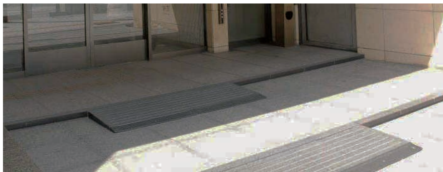
段差の解消：後付けのスロープで対処
