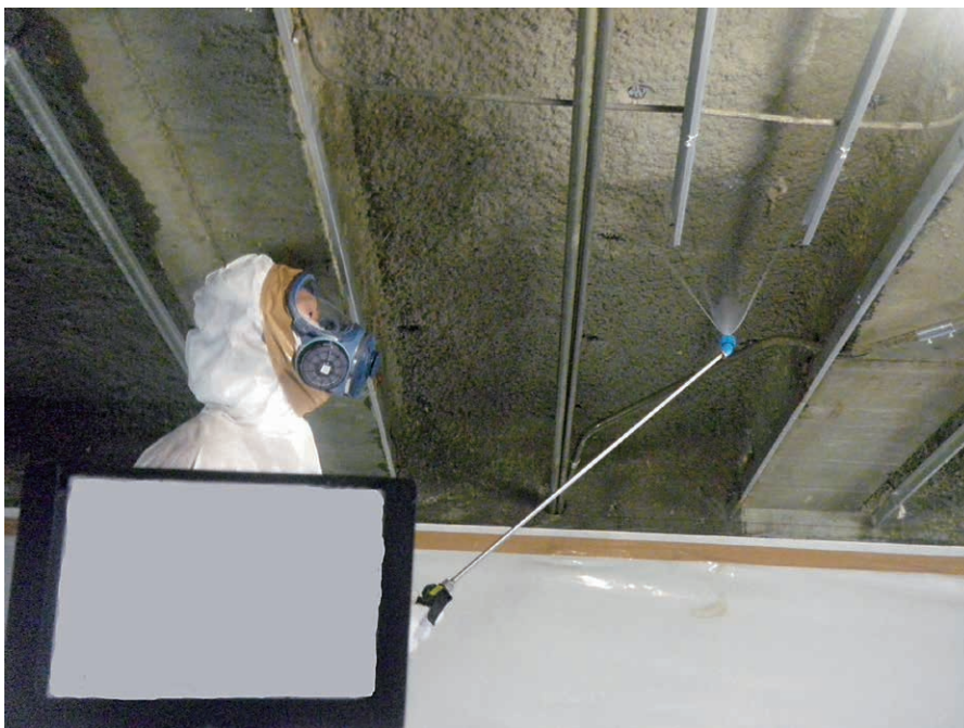
アスベストの封じ込め剤、噴霧作業
