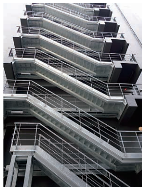
写真5 S造外部避難階段
