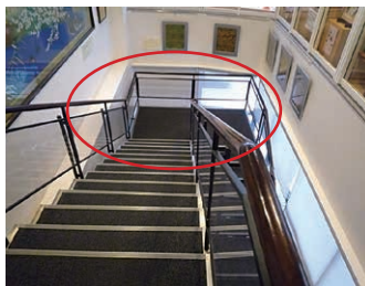
写真15 手摺(内部階段)
