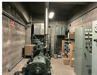
写真18 CB壁(地下階)
