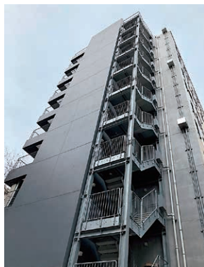
写真4 S造外部避難階段
