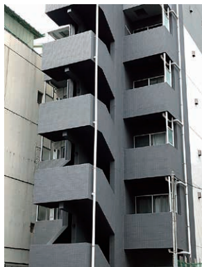
写真1 RC造外部避難階段
