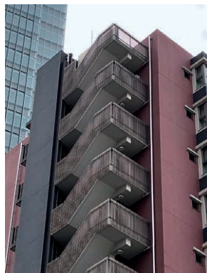
写真2 RC造外部避難階段
