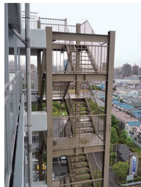
写真6 S造外部避難階段
