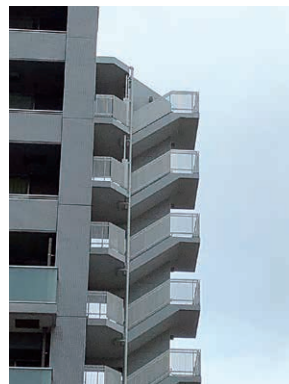
写真3 RC造外部避難階段
