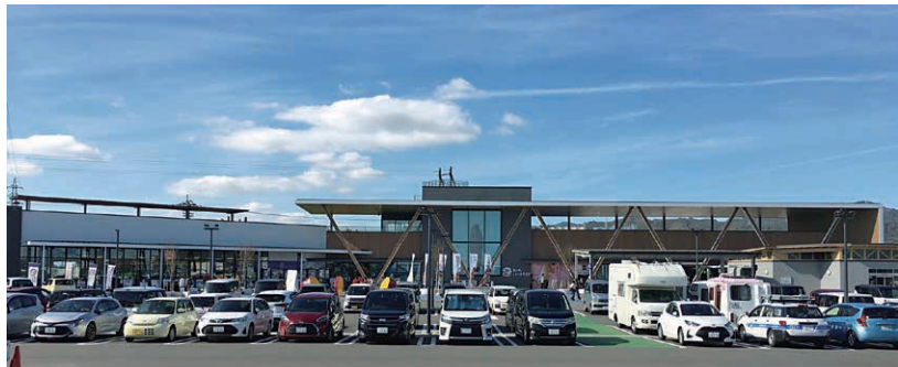
図1 前面駐車場からの全景
